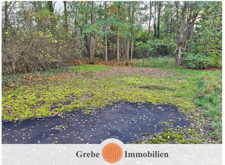
Bodenplatte aus den 90ern
